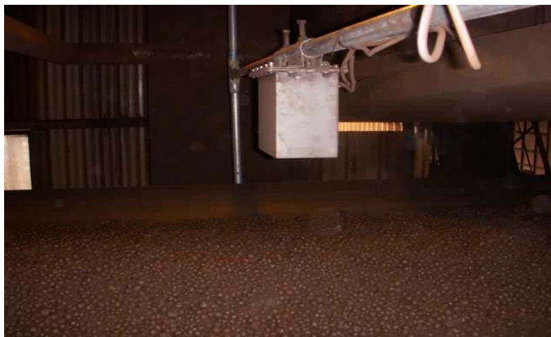
上图：铁矿石水分检测
