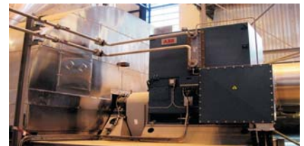
ID fan, 2 MW (redundant)
