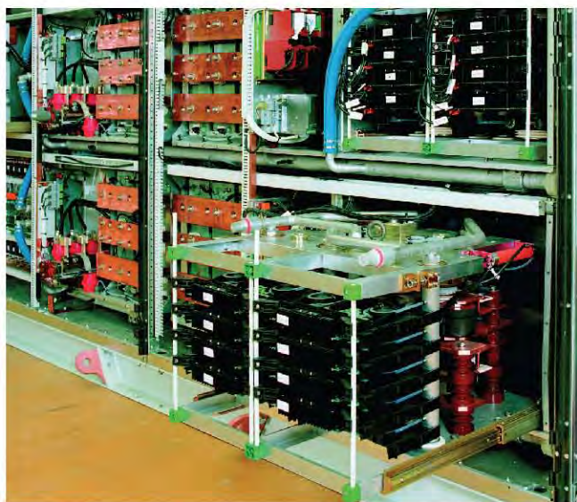
ACS5000 水冷逆变器相模块安装于滑轨上面。
