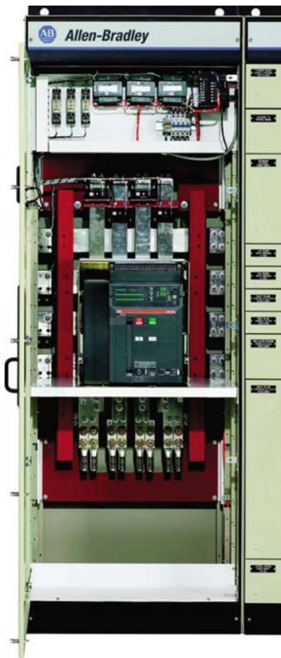
图17 空气断路器抽出式示意图
