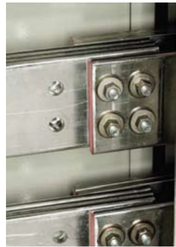
图11 水平母线连接
