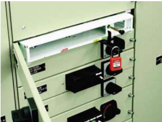
图32 断开位置（锁住的状态）
