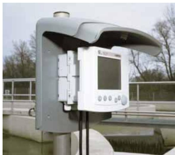
IQ SENSOR NET 184 XT，可同时连 12 支传感器
