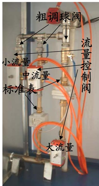
流量控制阀门及“进水箱”阀门，使水箱及管道中水充分循环，使水温均匀，观察视窗口直至无气泡为止。
