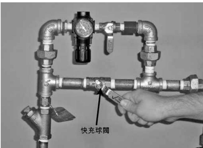
10. 打開AMTA上的快充球閥。讓壓力重新回到正常系統壓力。
