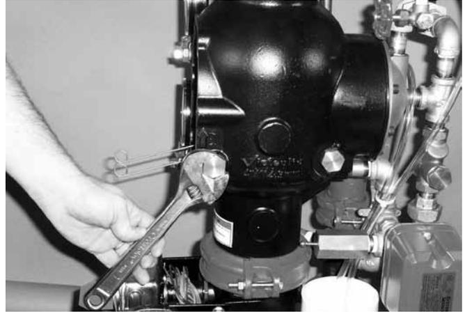
2. 將閥瓣軸套從閥體上拆下。
