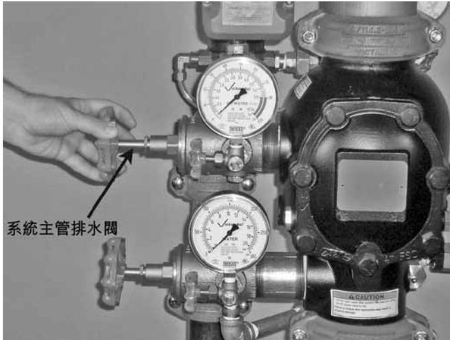
1. 開啟系統主管排水閥。確認系統已確實排水。
