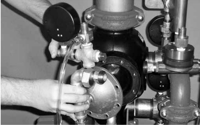
3. 從隔膜蓋板上拆除帽螺釘，並將隔膜蓋板/配件從閥門上拆下。
