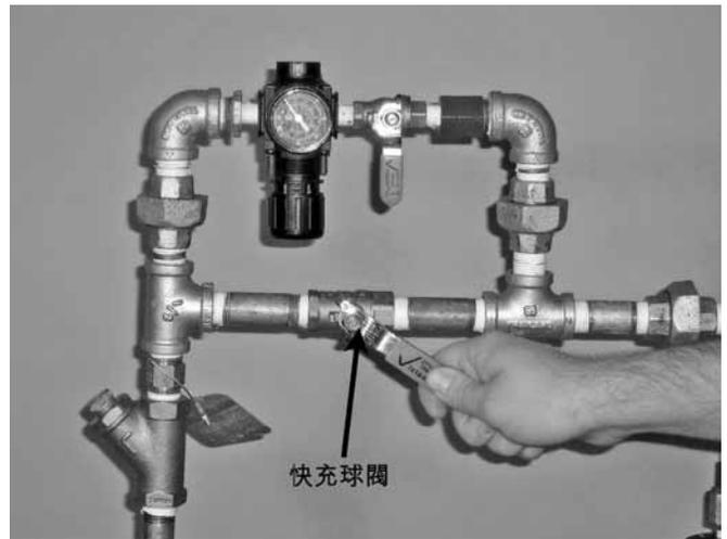
9. 啓動壓縮機或打開AMTA上的快充球閥 (快充球閥如上圖所示)，給系統充氣。系統充氣壓力最低13 psi/90 kPa/0.9 Bar。請參閱“供氣要求”一節。
