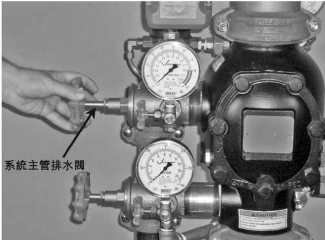
8. 打開系統主管排水閥，排出所有積水，並釋放系統氣壓。
