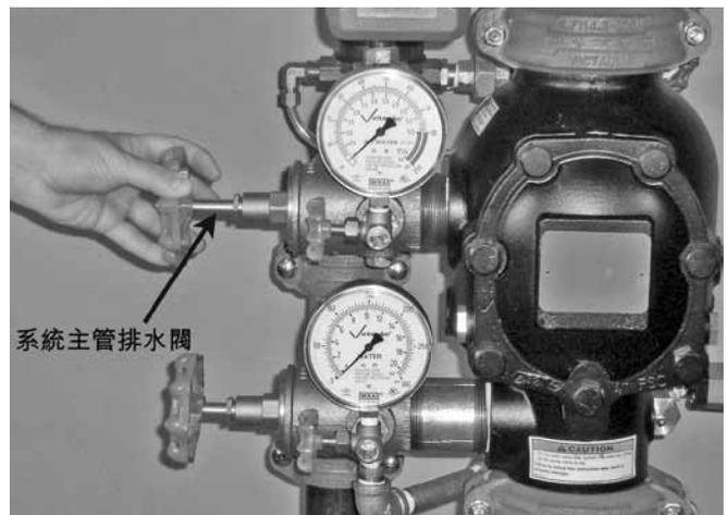
6. 緩慢部分開啓系統主管排水閥。確認水沒有從排水管流出。**備註：**如果水從排水管流出，則系統可能還沒有完全排幹積水。在這種情況下，請遵照執行“讓系統投入運行”一節中的所有步驟。
