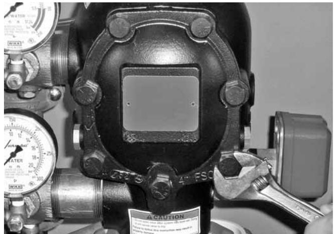
11. 在釋放完系統內的全部壓力後，緩慢鬆開閥蓋螺栓。說明：在鬆開全部閥蓋螺栓之前，切勿拆除任何閥蓋螺栓。
