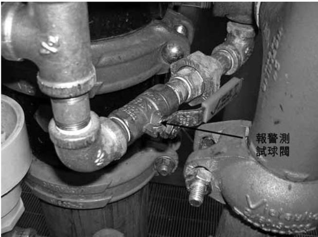
4. 打開報警測試球閥。確認已啟動機械與電氣報警器，且遠程監控站(如配備的話)接收到一個報警信號。
