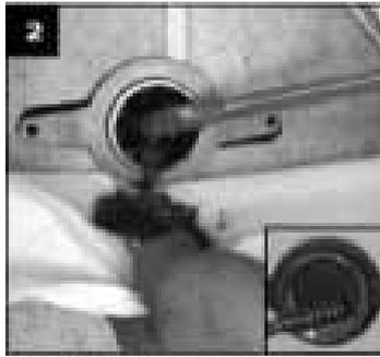
**步骤二、**根据小便器的尺寸在墙上开一个排水通道，用螺丝钻疏通出水通道，确保其内无杂质。
