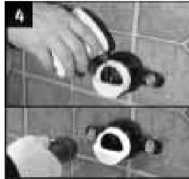
**步骤四、**向测试帽内倒入少量水，用手电筒照着看一下排水通道的斜面，以确保测试帽内没有水，不会倒流。
