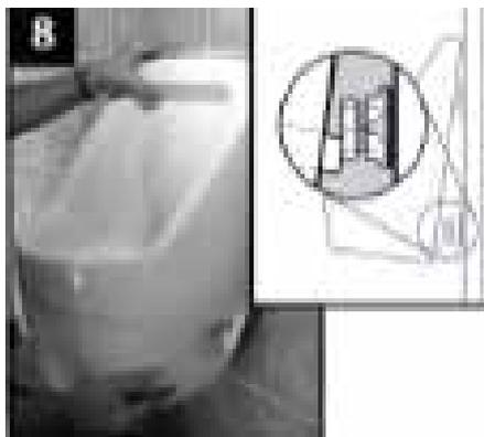
**步骤八、** 将小便器挂到已装好的托架上，检查小便器尾部导管与托架口是否吻合，如不吻合，调整托架，直到吻合为止。
