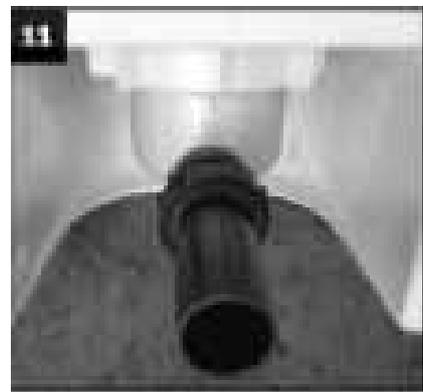
**步骤十一、** 将延伸管插入小便器本体，用2英寸的螺母和垫圈将其拧紧。
