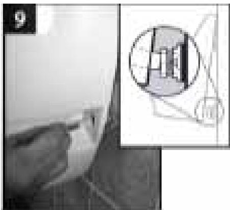
**步骤九、** 再次将小便器挂上，检查其出水导管与排水管是否吻合，如吻合了，在墙上标出另外两个固定孔位，然后再将小便器移开。
