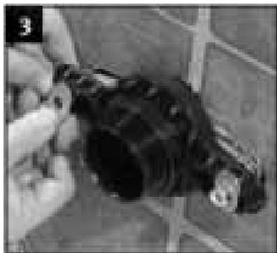
**步骤三、**将万维连接件安装到进水口上，连接件与进水口法兰之间用三个垫片隔开，然后，再安装排水管测试帽。
