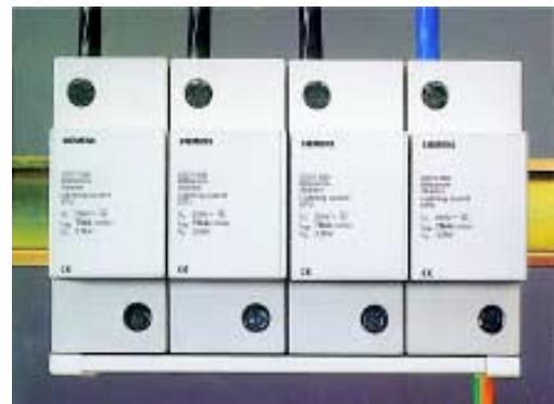
分支配电屏中与小型断路器一起安装的过电压保护电器
