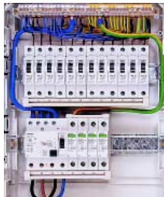
主配电屏中安装的避雷器
