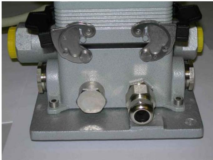
图 06: 缆线进口和 VISATRON 设备底部的终端电阻
