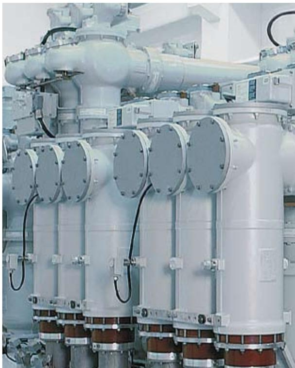
8DN9型气体绝缘金属封闭开关设备一个最基本的特点就是由多功能模块化系统带来的高度灵活性。
