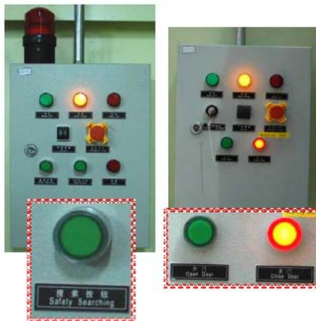
图1 棚屋内的搜速按钮照片（左）；棚屋门外的关门和开门按钮照片（右）
