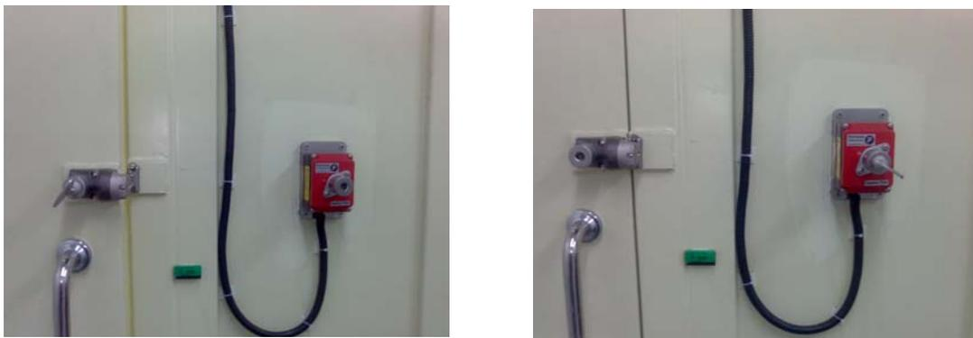
图4 实验棚屋人员进出小门；开启状态（左），连锁状态（右）
