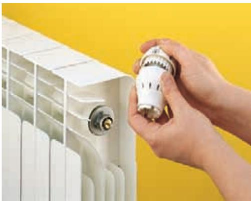
在将手柄旋至所需位置后，向上拉手柄可以将其卸下。建议不要改变传感器位置，以免温控头刻度失准
