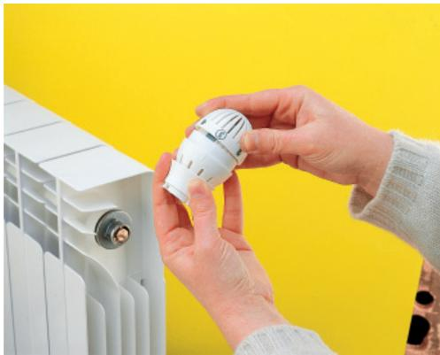
插入限制夹后，采用前面介绍的方法将温控头安装到阀体上去。
