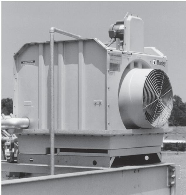
玻璃钢结构将经典的 Marley Aquatower 带入了 21 世纪。此 Aquatower 将 Aquatower 经过验证的冷却塔技术和玻璃钢经过验证的耐腐蚀性结合在一起。
