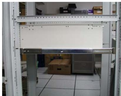
图 3.20 服务器安装在机柜上
