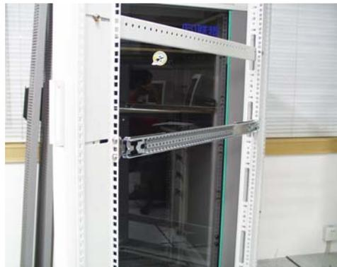
图 3.17 导轨安装在机柜上
