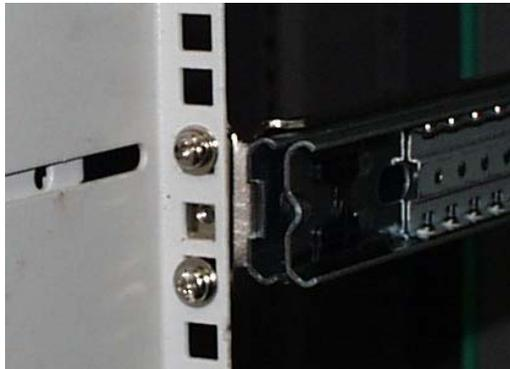
图 3.16 导轨托架的安装
