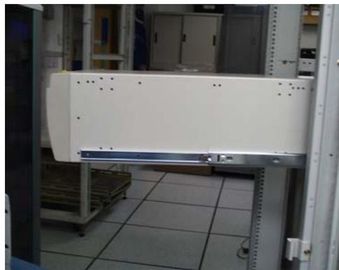
图 3.19 内导轨安全锁片被锁住
