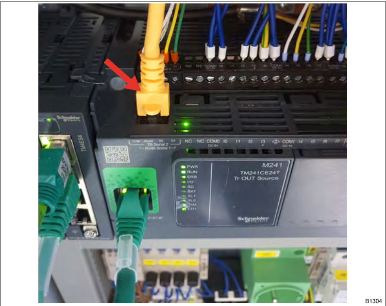
插图 2: Modbus RTU 至 PLC 的电缆
