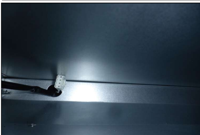
按装新风阀时先穿大头的电线在穿头小的电线 注意不要损坏电线 注意橡胶圈一定要安装到位
