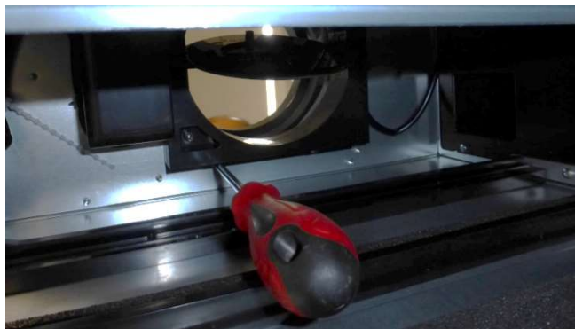
松开并取下图示固定新风侧风阀组件下方的两颗固定螺钉
