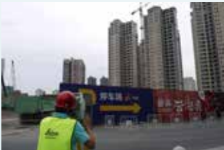
■ 施工竣工测量
