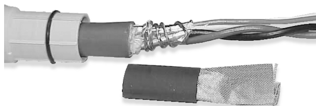
屏蔽加蔽线在外露的屏蔽金属箔上绕两圈
