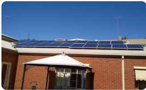
安装地点：澳大利亚-墨尔本 项目容量：6kW 机器型号：MG6KTL
