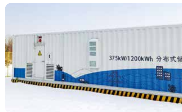
安装地点: 佛山 项目容量: 375kW/1.2MWh 机器型号: BD100KTR, BD250KTR-T
