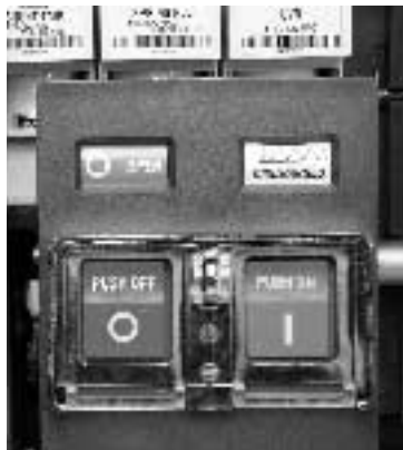
图2 ON - OFF按钮可带锁盖板
