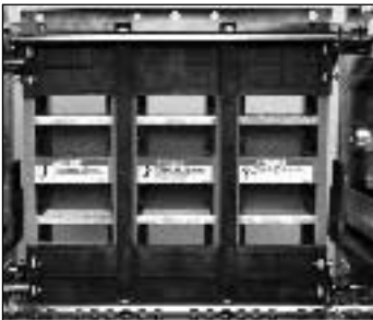
图13 安全挡板在打开位置
