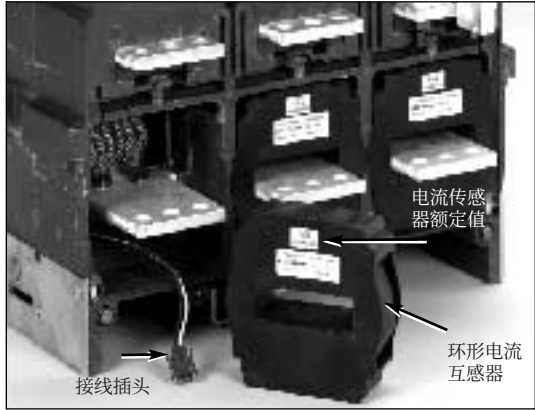
取下盖板的电流互感器和一只取出的互感器
