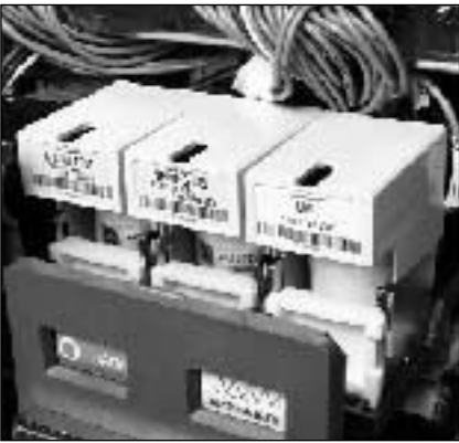
图7 装有 分励脱扣器,弹簧释能装置和欠电压脱扣器
