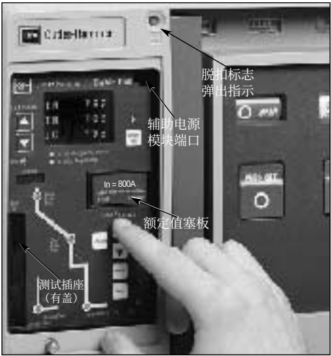
安装的DigitripRMS1150 可编程脱扣装置
