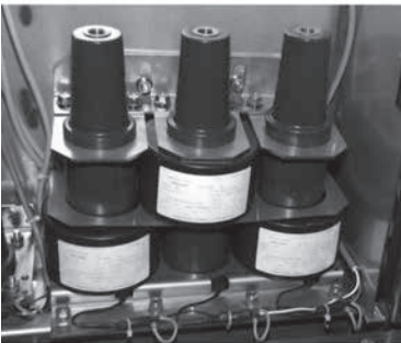
在外锥形套管上的穿芯式电流互感器
