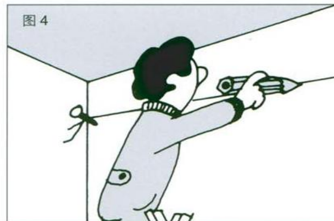
Set perimeter trim on exact height. 设定墙周边面板安装的确切高度。
