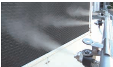
作为节电措施的冷却用途示例(配管由客户施工)
