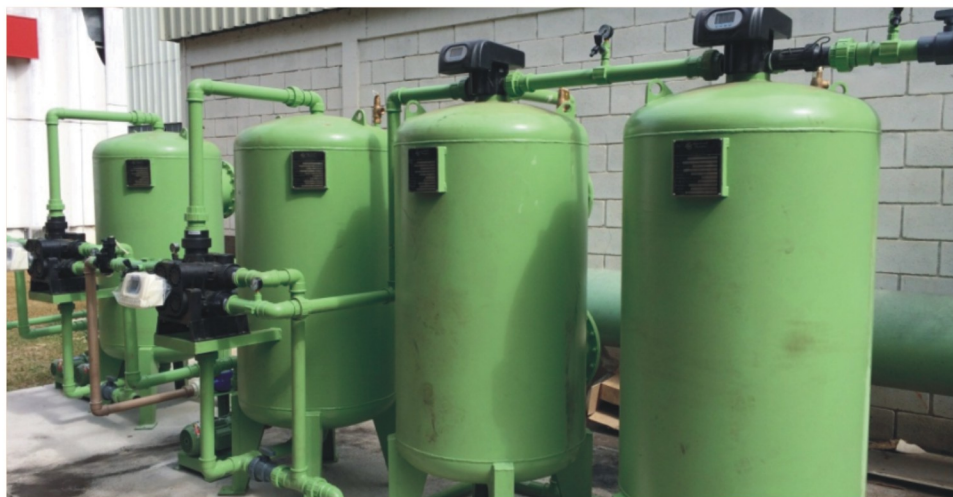
● F78B自动过滤阀/F75A ● 砂滤，除铁过滤，活性炭过滤装置(巴西)
