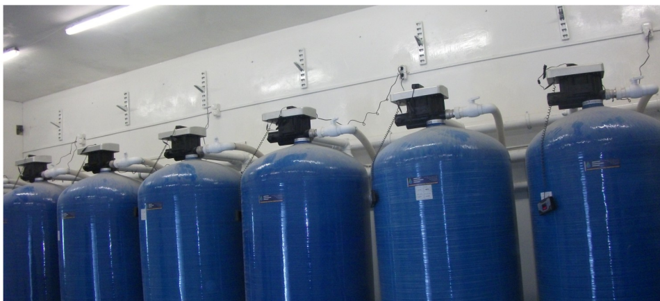
● 使用润新F77B自动过滤阀 ● 商用过滤装置(俄罗斯)
