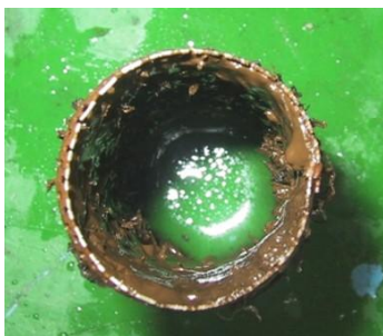
图 3. 过滤器被异物堵住事例
