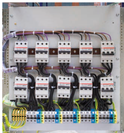
配断路保护器的交流输入面板 / AC input panel with breakers
