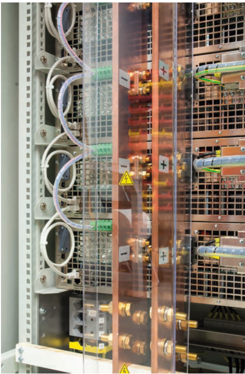
直流总线端子 / DC bus terminal
