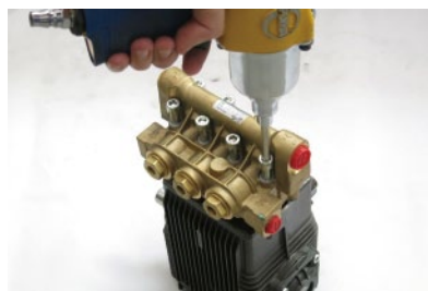
1. 使用气动枪移除 8 个泵头螺栓
