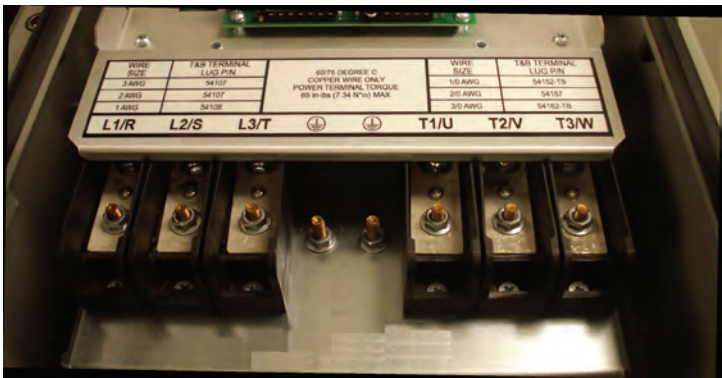
图 11: 电源端子尺寸 4 和 5
