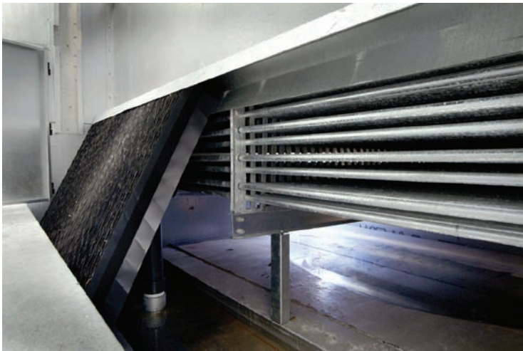
盘管位于 MH 闭式冷却塔较低处，这样便于清洁和检查。
