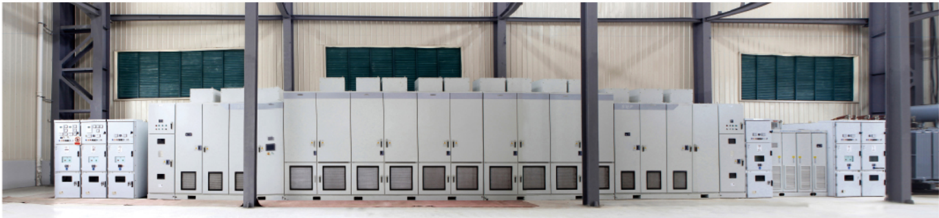
AS800-12000-T10-PAD 高压变频器 / 核电水泵测试台应用案例
