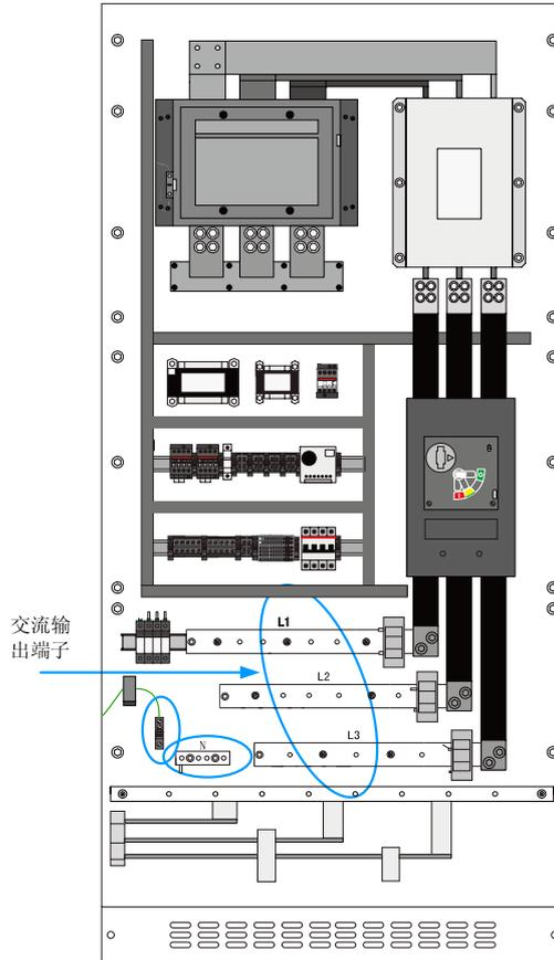
图8-6 交流侧接线端子
