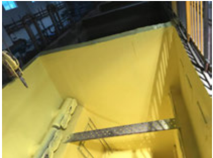
本钢板材发电厂超滤膜池
