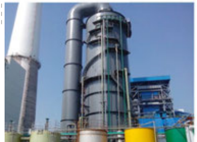
唐山市经安钢厂脱硫装置防腐项目
