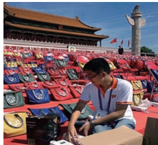
在观礼台安装固定电话和宽带网络
