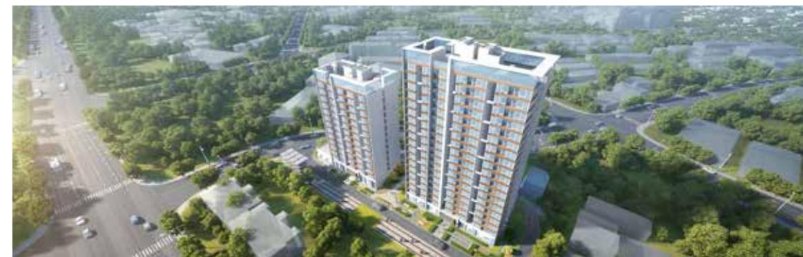
广州港筑港二村公共租赁房项目——黄埔区旧城改造先行先试标杆示范项目
