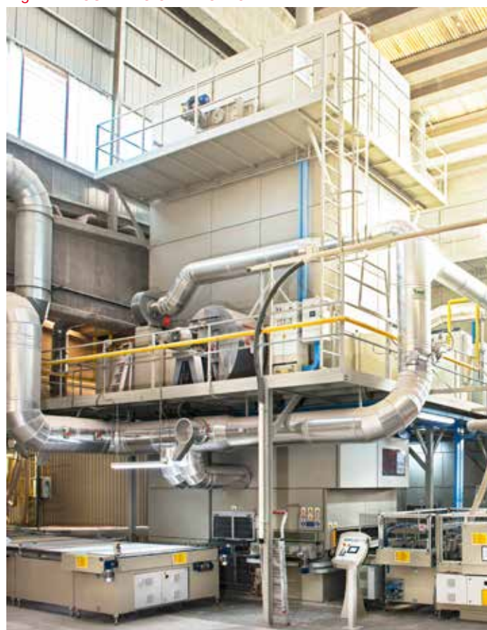
Fig. E - RECUPERACIÓN DE CALOR
