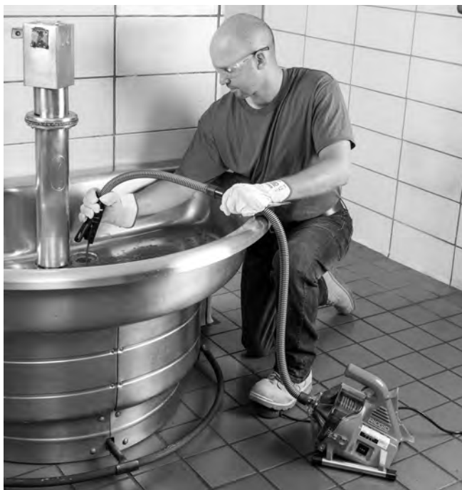
Figura 11 – Recuperación del cable
