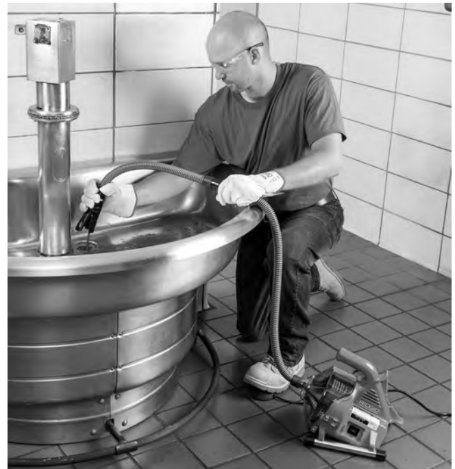
Figure 11 – Récupération du câble
