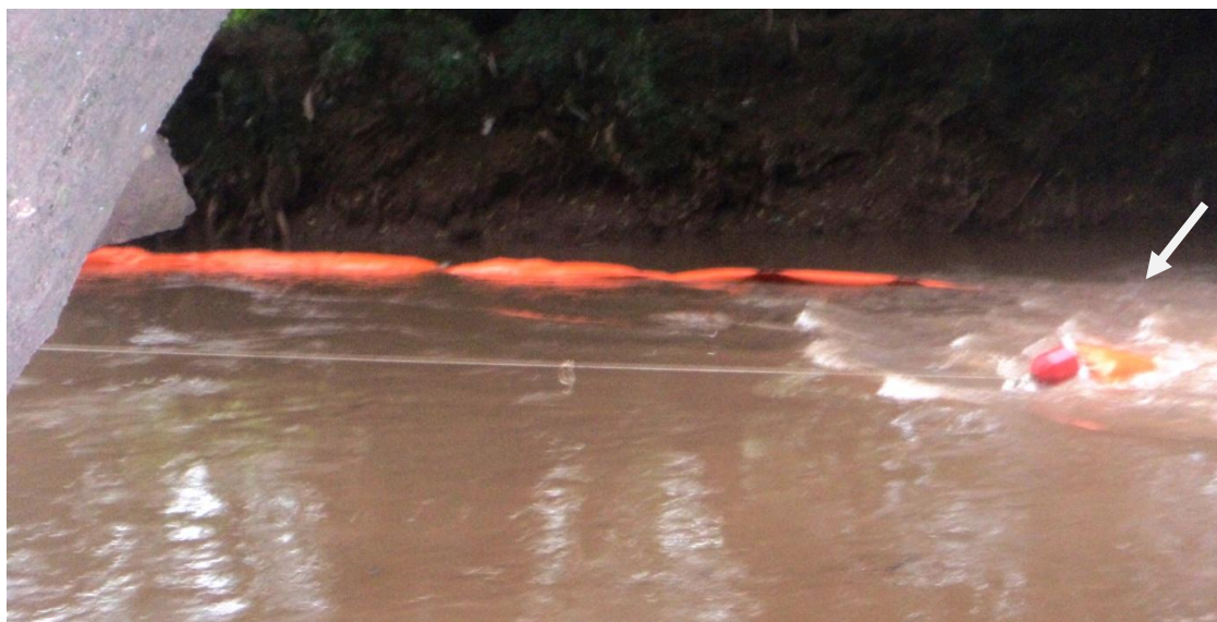
Figura 41 – Contenção inadequada de uso de mantas absorventes.
