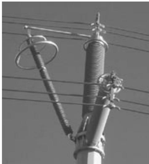
Torre compacta de 400 kV sin cable apantallado aéreo. Aisladores protegidos por TLA en fase superior.
