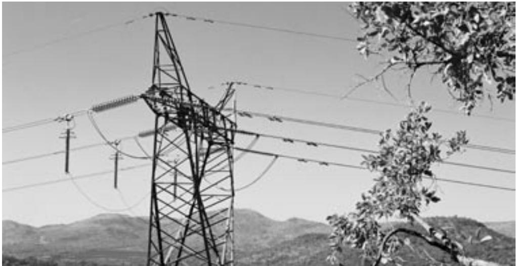
El peso reducido permite la instalación en estructuras existentes y el revestimiento de polímero ofrece mayor seguridad para los equipos de línea y las personas y animales que pueda haber en las proximidades de las líneas al producirse sobrecargas.
