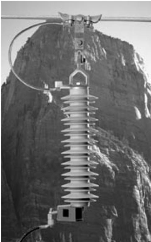
La figura muestra un TLA para 145 kV, que incluye componentes estándar como el descargador PEXLIM y un monitor EXCOUNT-II.
