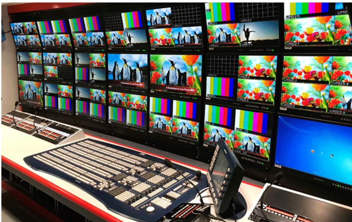
Figura 38 - Puente de monitoreo en el área de realización
