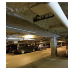
地下停車場 Basement Parking
