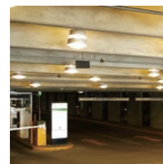
地下停車場 Basement Parking
