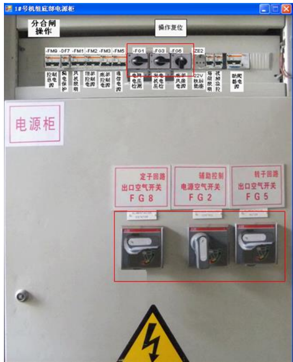
图 2-72 操作电源柜开关
