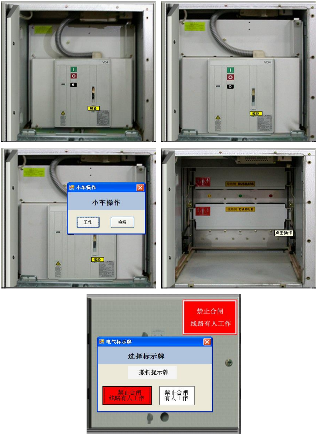
图 2-76 组线开关柜小车操作
