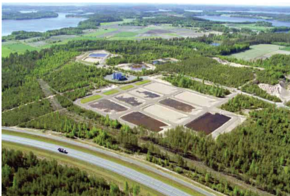
芬兰南部 Kuivala 水处理厂鸟瞰图。该厂使用 FILMTEC™ 极低压 (XLE) 反渗透膜去除饮用水中含有的氟化物。照片由 Kymenlaakso 水务公司提供。
