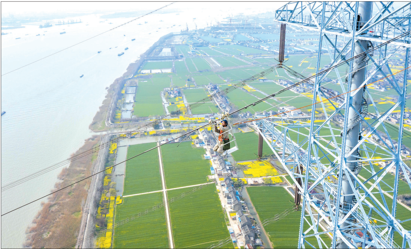
3月10日，在泰兴变电站至无锡斗山变电站的500千伏兴斗线江阴长江大跨越63号铁塔上，电力“蜘蛛”人正带电更换光缆阻尼线夹。当日，国网江苏省电力有限公司组织人员在346.5米高空对500千伏江阴长江大跨越进行带电消缺作业，确保我省北电南送重要过江通道安全畅通。 史俊 撰文
