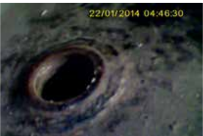
使用6mm长焦镜头 (VSA2-1)检查储罐孔洞
