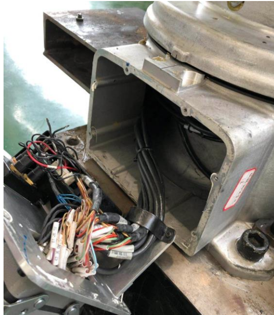
图 13-2 底座内部线缆
