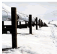
油气管线的腐蚀检测
