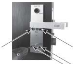
图 18 用 8mm 钻头分别在 门两侧钻 4 个固定螺 钉过孔。
